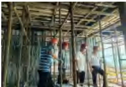
大家在现场实地检查
