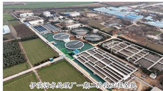
伊滨污水处理厂一期二阶段工程全貌
