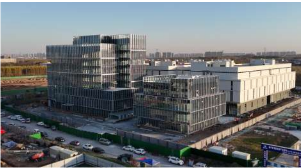
建设中的新开普智能制造产业基地项目外景 (关昊航/图)
